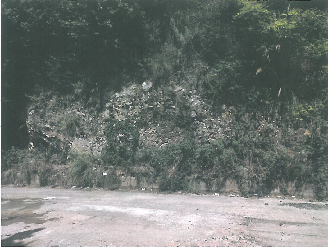
Foto 1 – Immagine realizzata durante il rilevamento geologico/ geomorfologico di dettaglio che mette in risalto l'affioramento presente nelle vicinanze dell'area di progetto (Breccia Calcareo Cementata)
