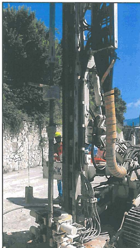
Foto 8 – Esecuzione SPT in sondaggio S2
